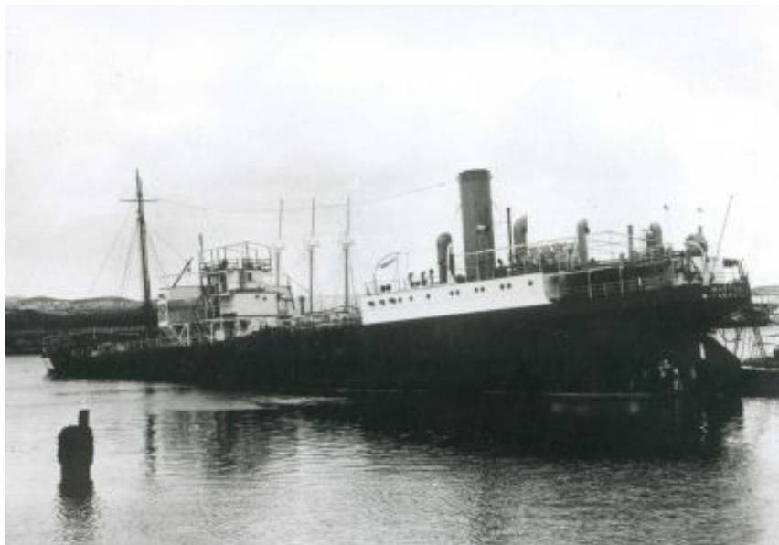
7) Martina 1924 (roepnaam PJAH) Diensttijd 1924-1954 Bouwer : R.D.M. Rotterdam. (bouwnummer 093). Tonnage : 2.698 brt., 1.486 nto. en 3.269 dwt. L X B X D X H : 92,96 X 15,34 X 4,60 X 6,09 mt.
